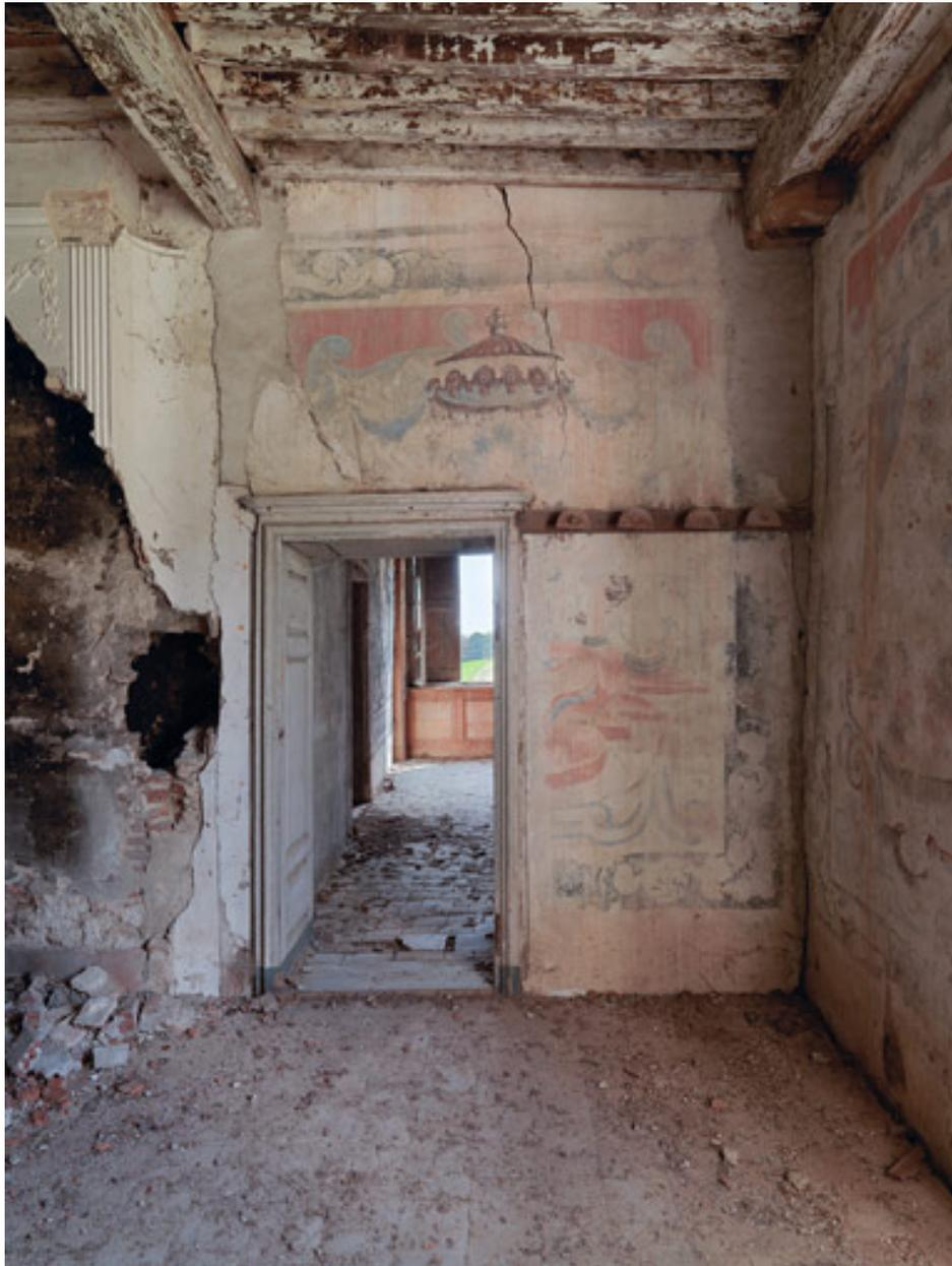
Mur sud : vue du panneau à droite de la cheminée (endommagé par le percement d'une porte).
