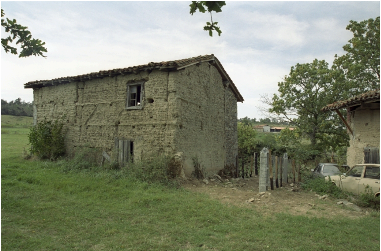
Cezay, Prandière (1987 A1 13), type C1. Vue d'ensemble de la grange-étable.
