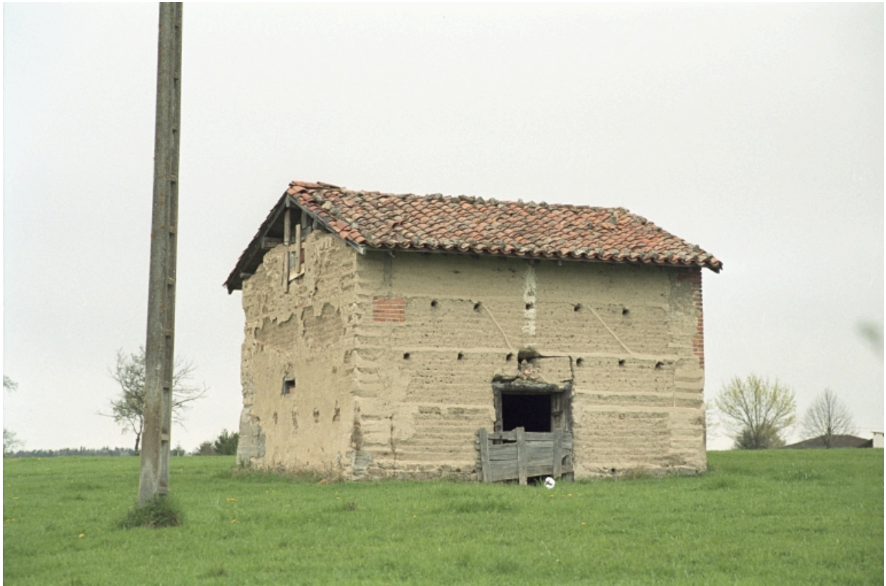
Arthun, Ribot, grange étable (1987 A1 667). Vue d'ensemble.
