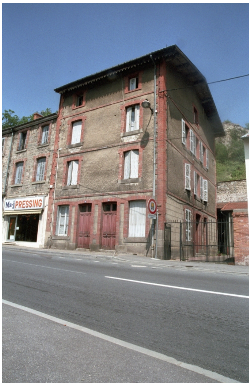
Boën, îlot 17, Lyon (rue de) 93 et 91. Vue générale de la façade sur rue.
