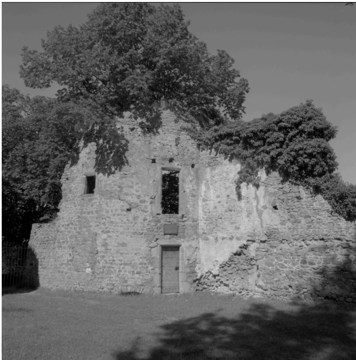
Premier baile, première enceinte, angle ouest : vue de la tour ronde dite tour du Mandement (tour n°13 du plan), du sud-est.
