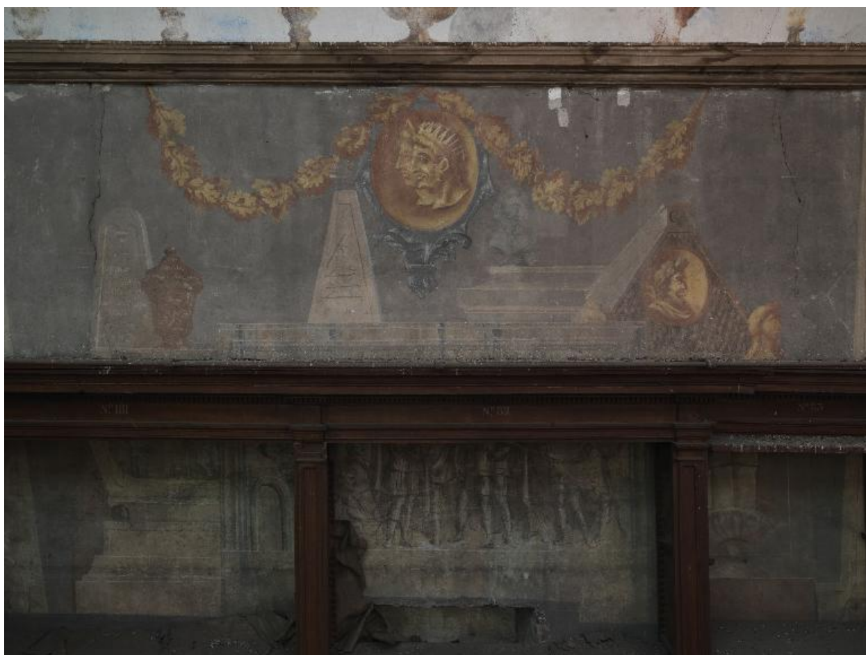
Mur nord, vue d'ensemble
