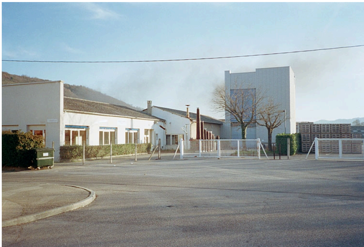
Service technique vu du nord-ouest
