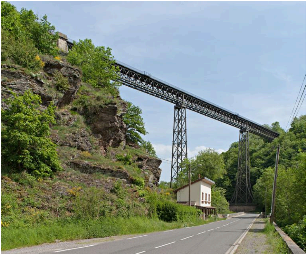
Vue générale du viaduc depuis la route D37.
