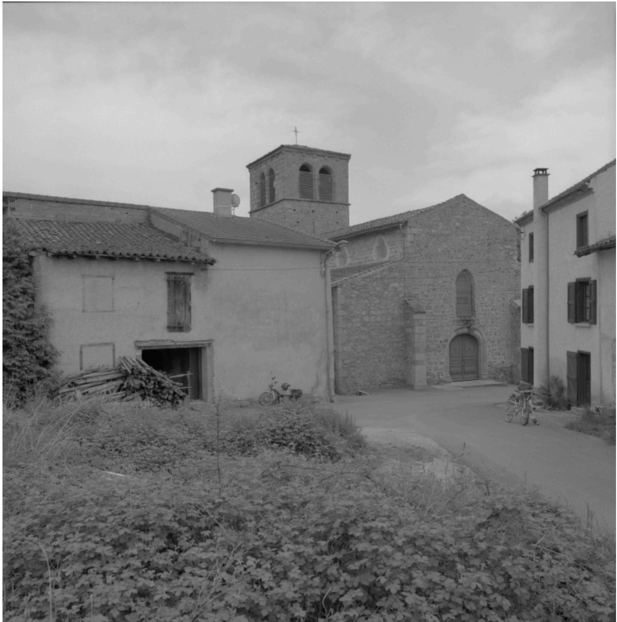
Vue générale depuis le nord : façade antérieure.
