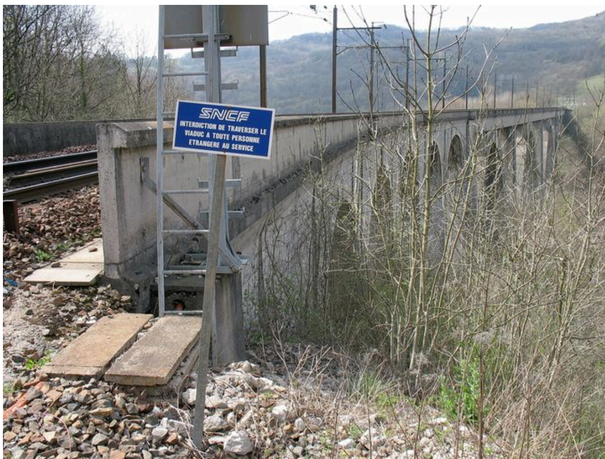
Vue du côté amont (depuis la rive gauche)
