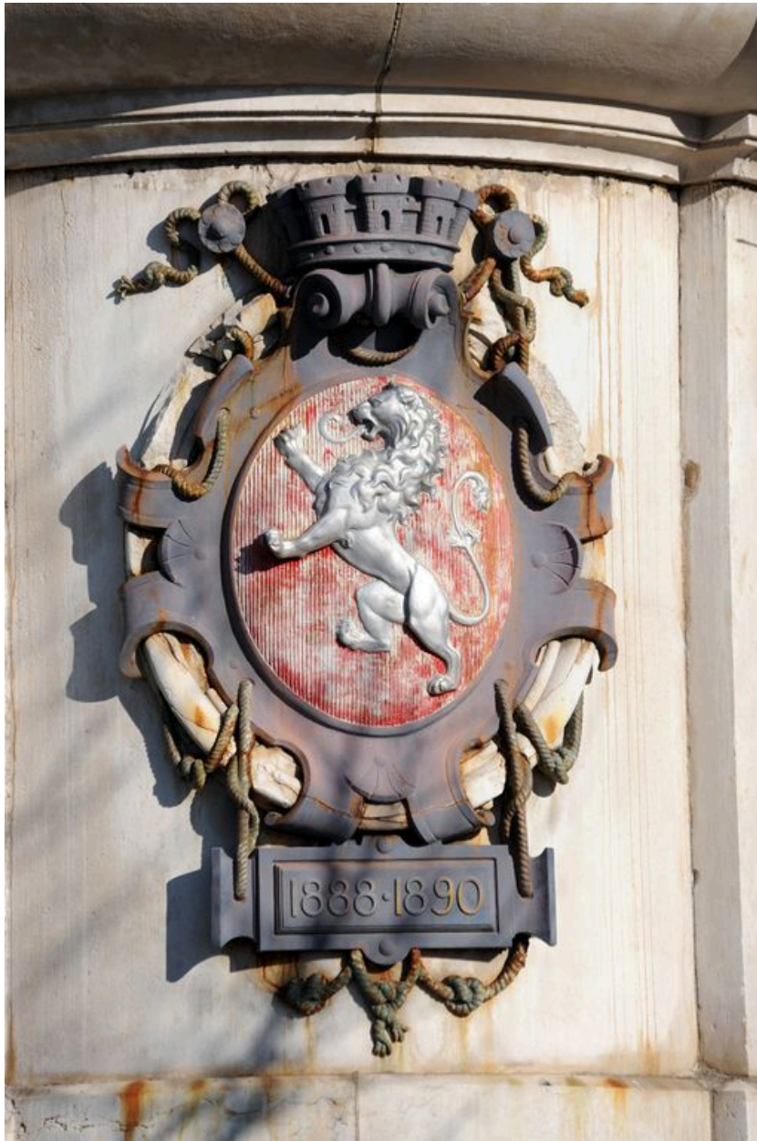
Culée gauche, face aval, vue de détail : armoiries, dates (depuis la rive gauche)
