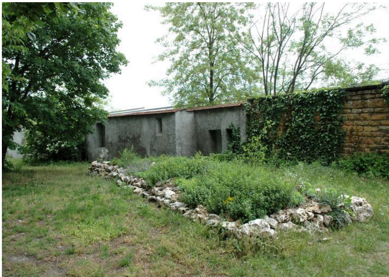
Mur de clôture sud-ouest depuis l'enclos du couvent, trace des ouvertures des anciens pavillons du télégraphe
