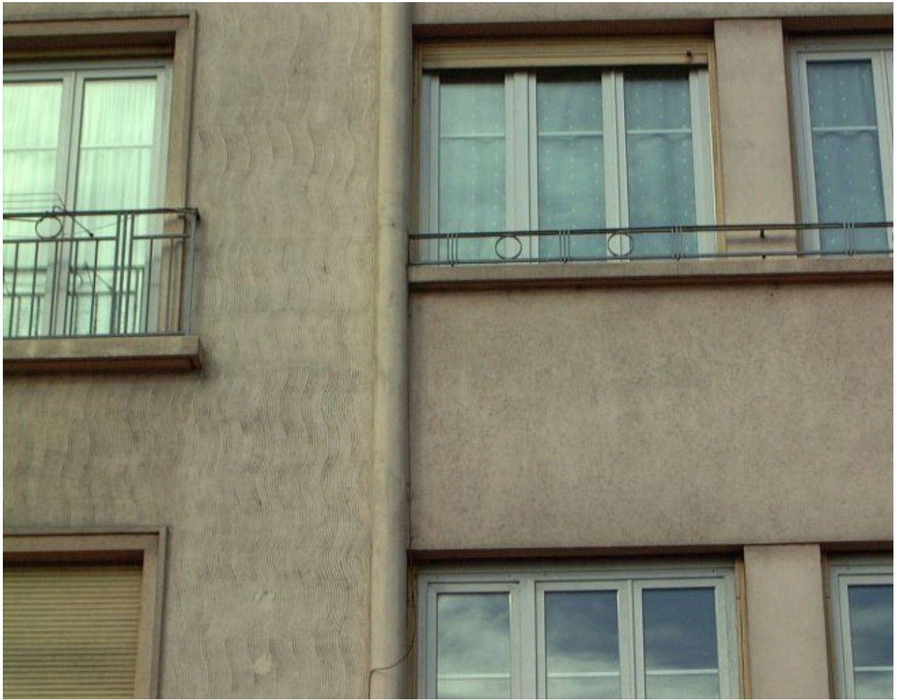
Détail de l'enduit de façade
