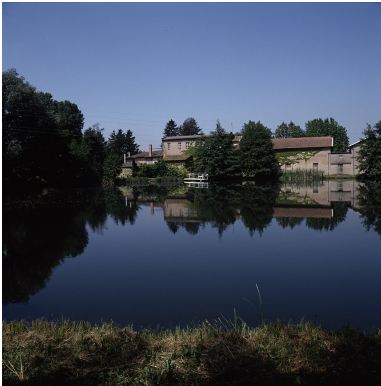
Vue d'ensemble depuis l'étang (bassin de retenue).
