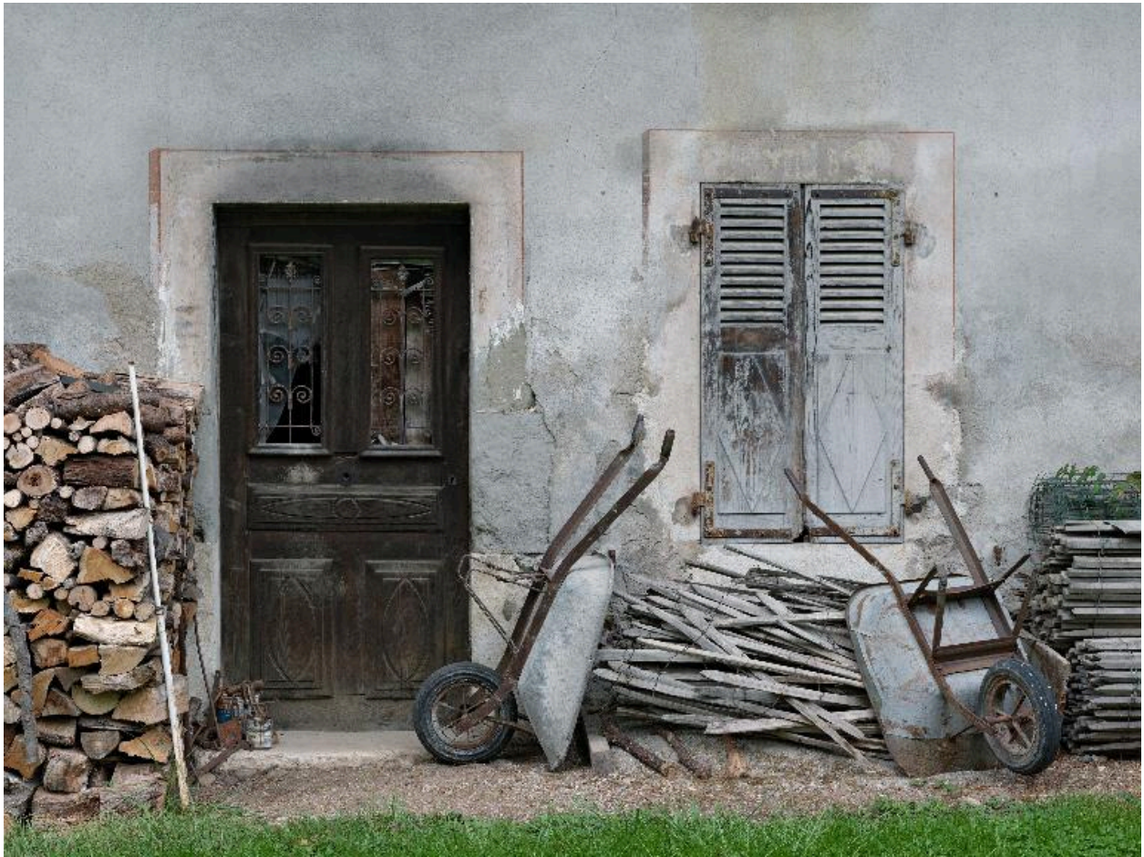
Détail de la façade principale : porte d'entrée et fenêtre du rez-de-chaussée.
