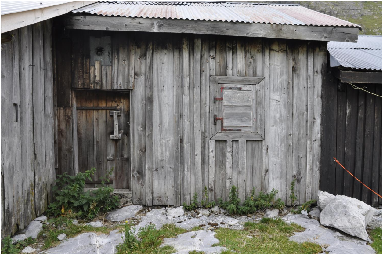
Vue de la façade antérieure est
