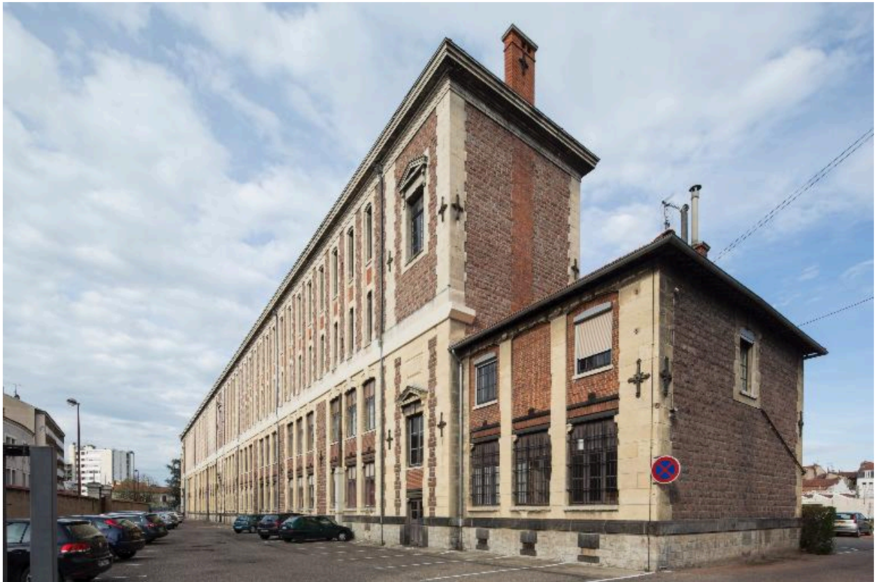
Bâtiment A. Façade rue de Noël côté sud
