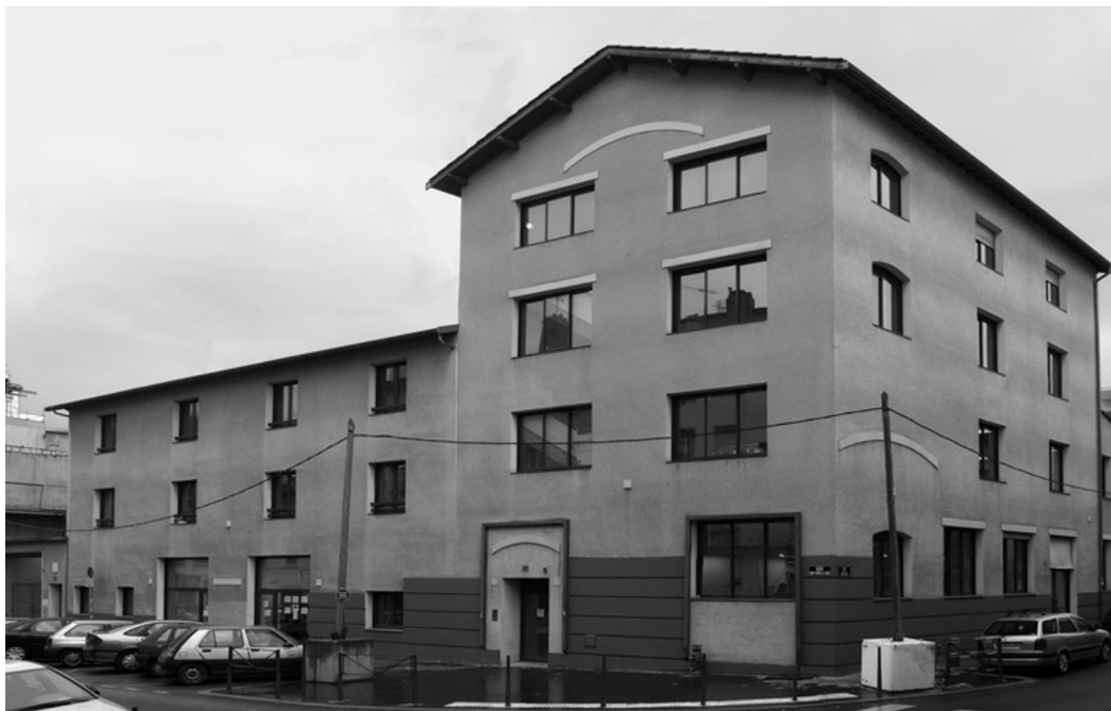
Vue d'ensemble du nord-ouest
