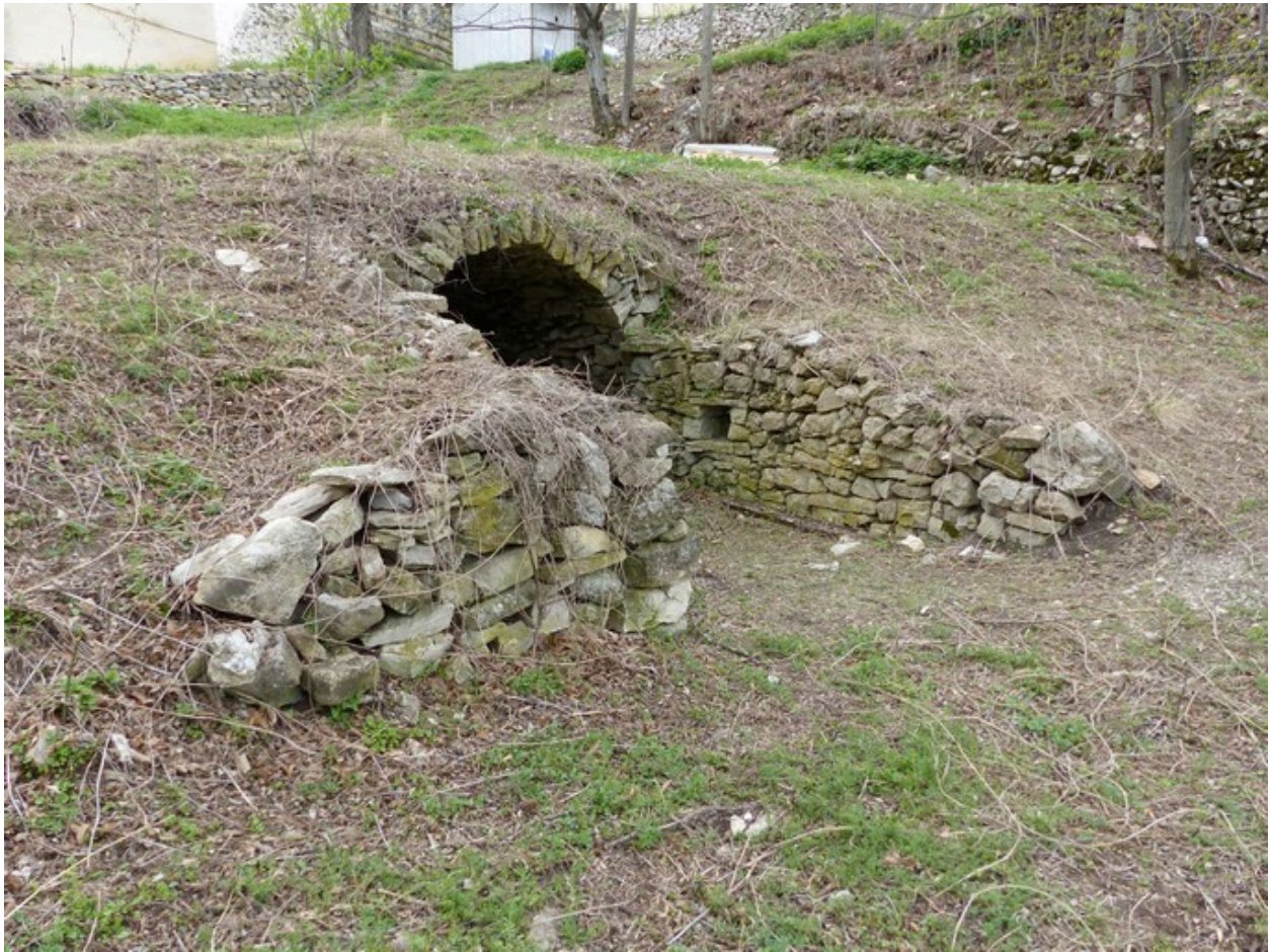
Vue d'ensemble prise du nord-ouest.
