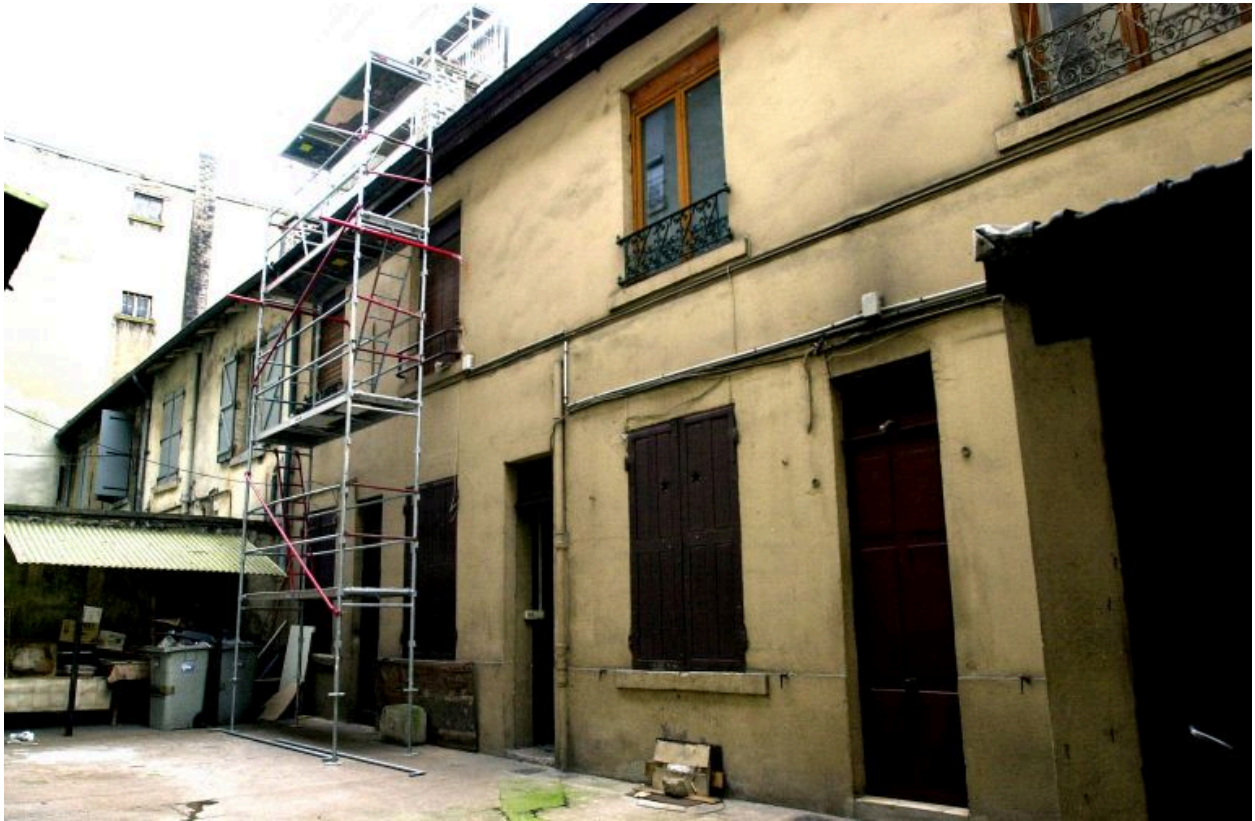
Elévation principale depuis le nord
