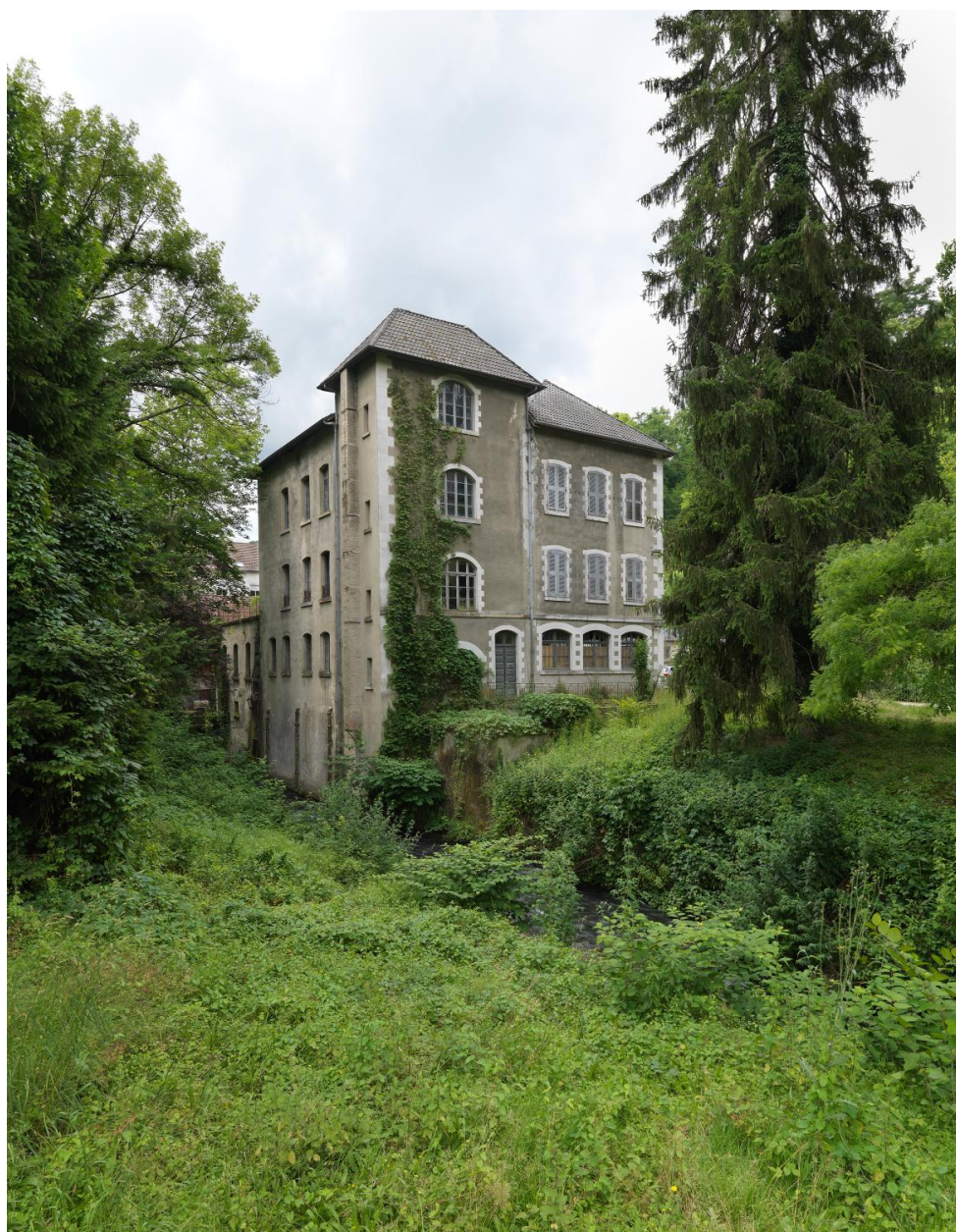
Vue d'un bâtiment
