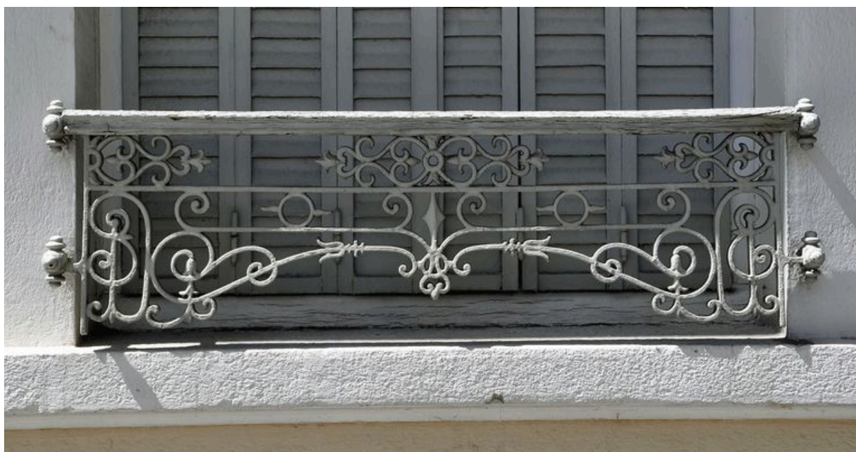
Garde-corps du premier étage
