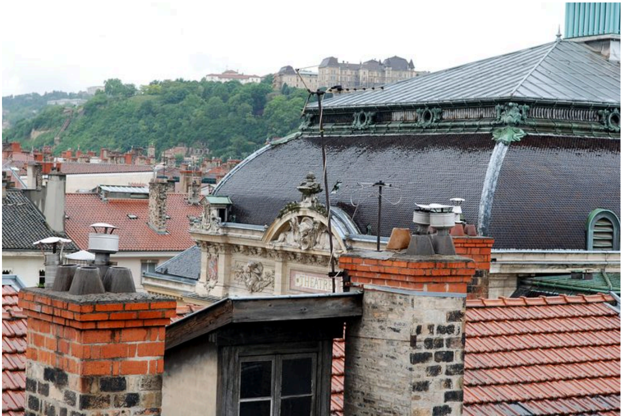
Toiture et fronton depuis le groupe scolaire Lamartine
