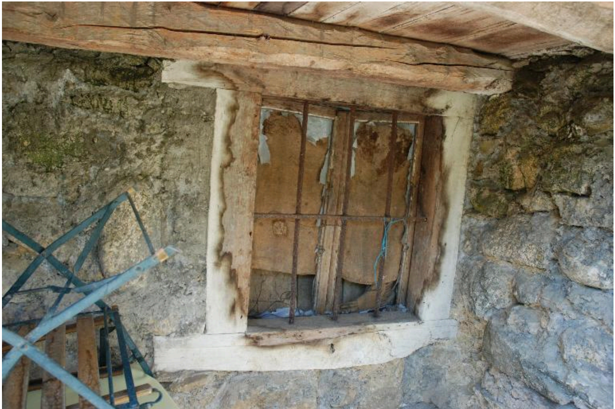
Détail de la fenêtre de la cave à vin.
