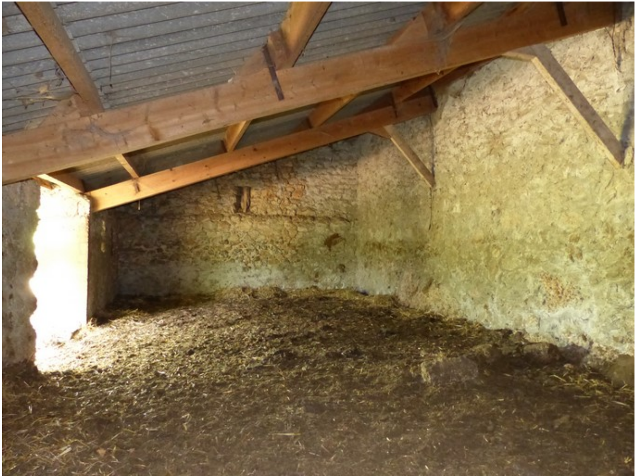
Etage de soubassement, bergerie. Vue de volume prise de l'est.
