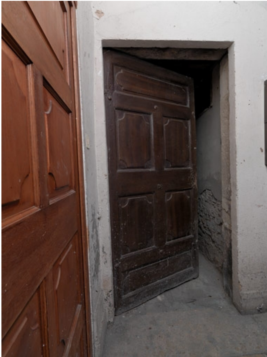
Bâtiment R. porte des dépendances du rez-de-chaussée
