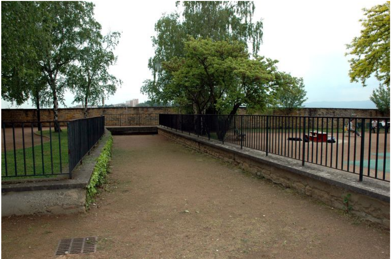
Mur de clôture sud-ouest, ancienne rampe d'accès au couvent depuis la montée du Télégraphe, aujourd'hui comblée.
