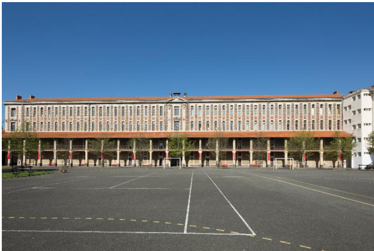
Bâtiment A. Façade sur cour
