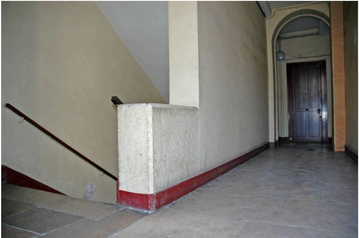
Palier du 1er étage et accès au couloir desservant les appartements
