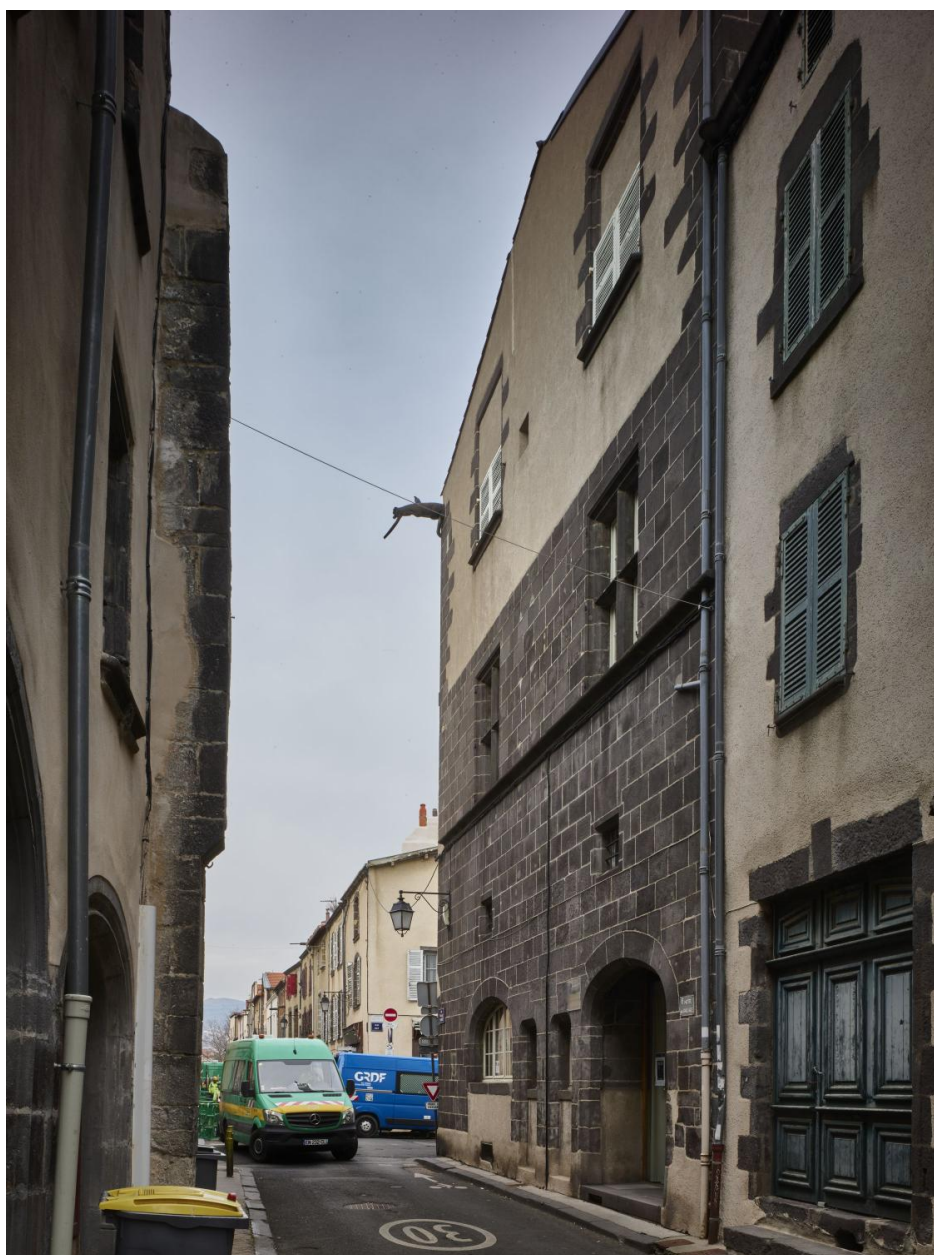
Elévation latérale, rue de la Rodade
