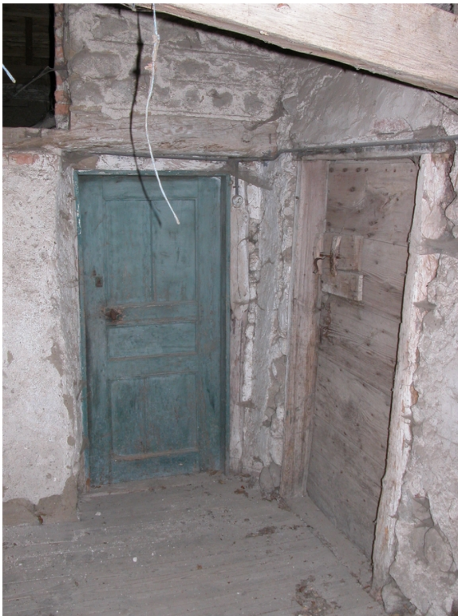
Vue intérieure du logis : couloir de distribution (à l'étage).
