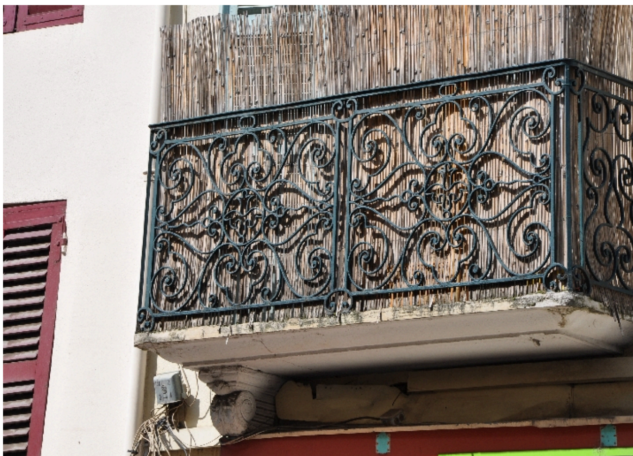
Détail d'un balcon
