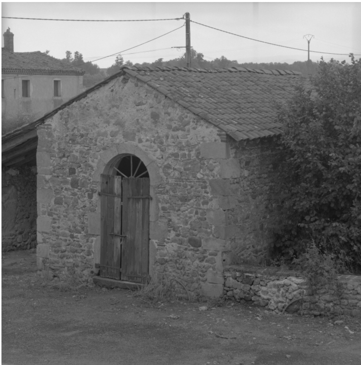
Vue de la remise, depuis le nord.
