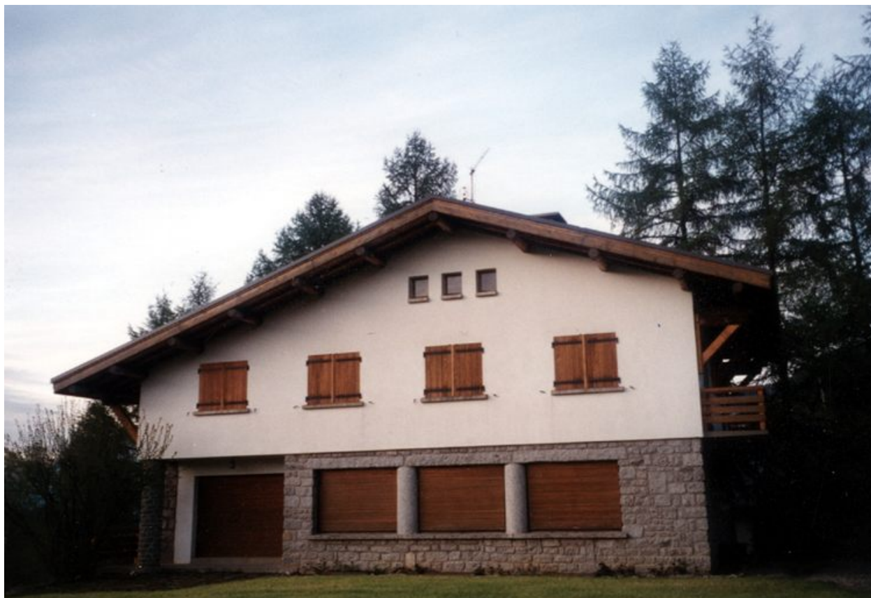
Façade principale. Etat en 1996
