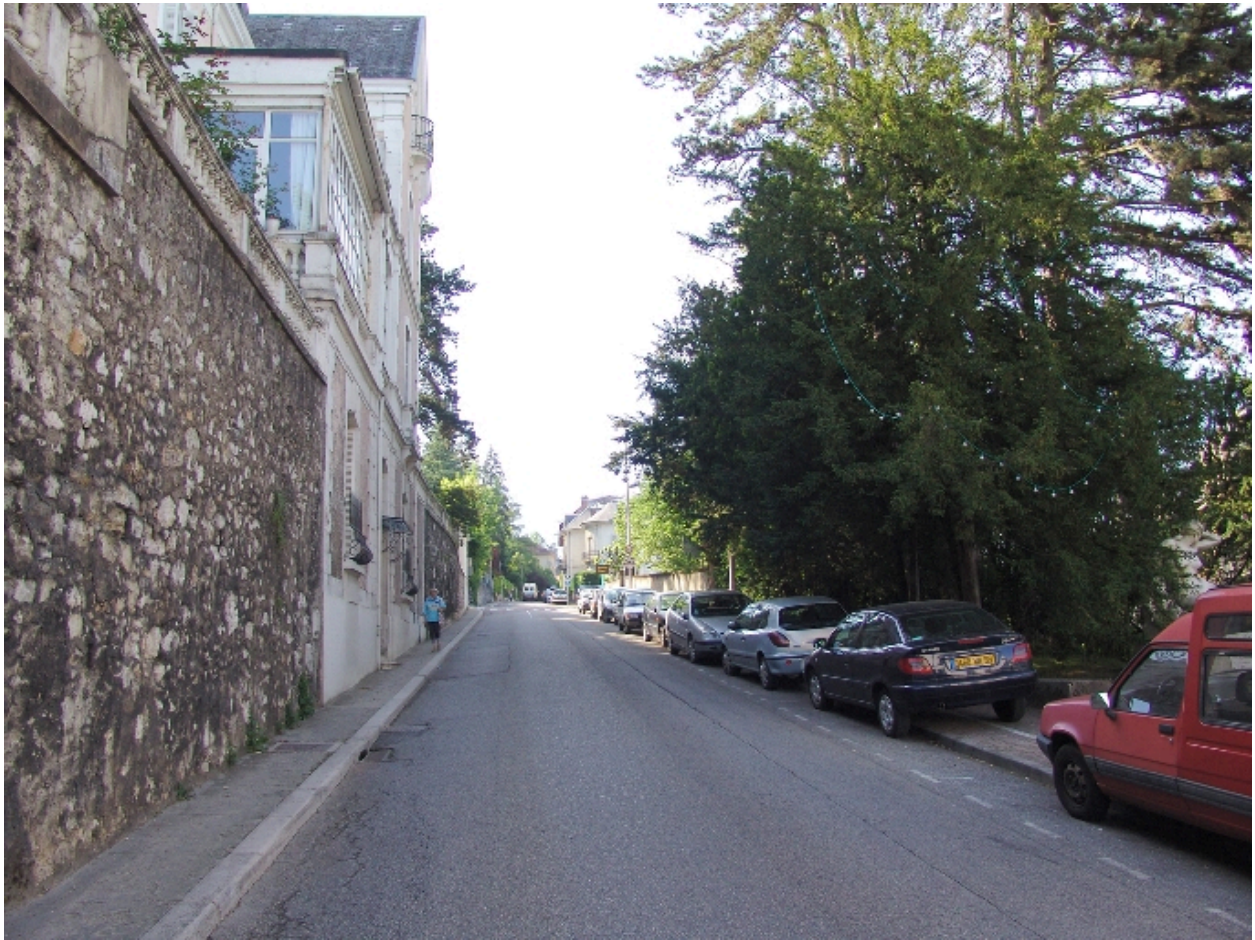
Vue depuis le nord
