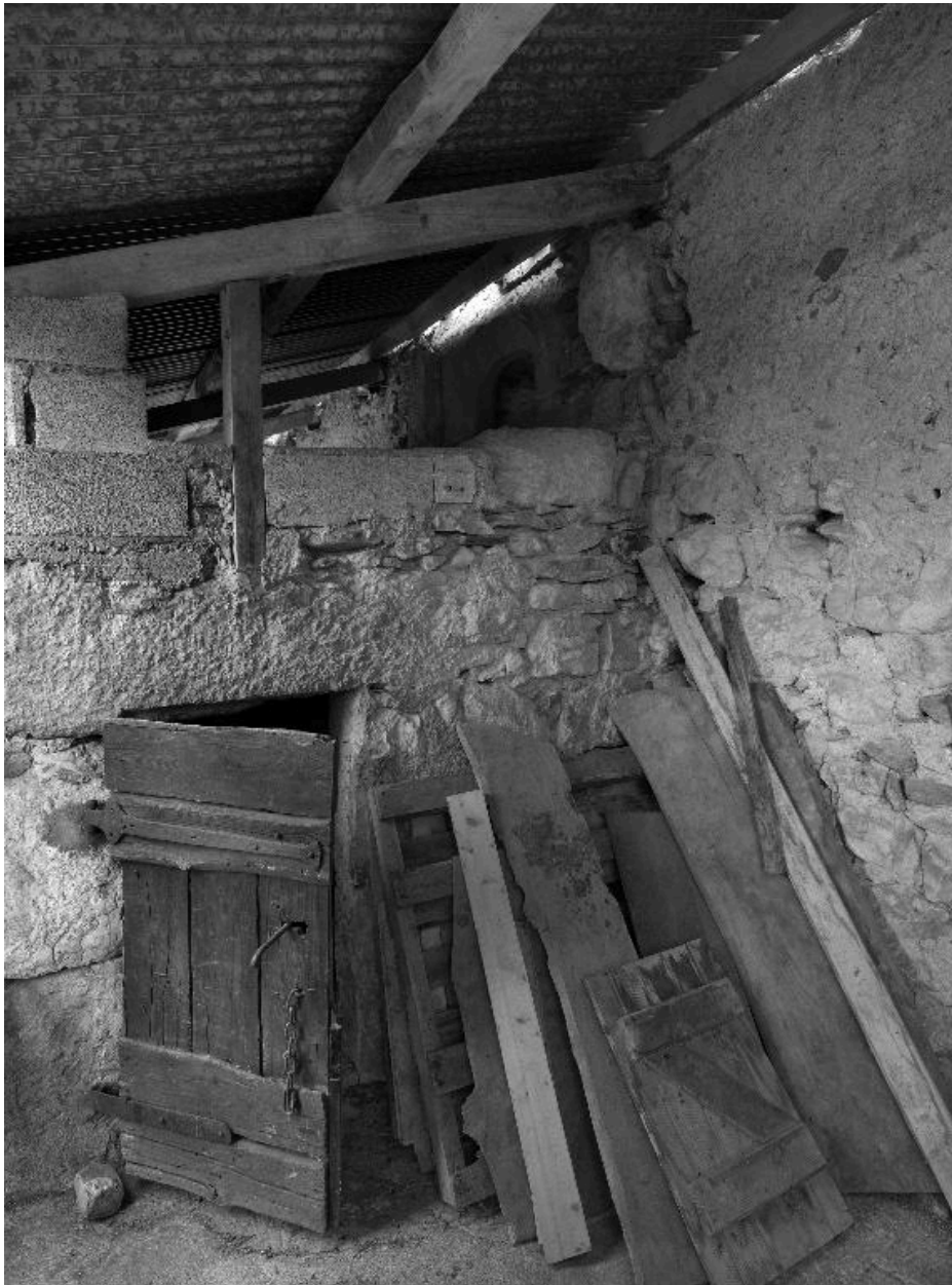
Détail de la porcherie située sous l'appentis du pignon ouest de la ferme.
