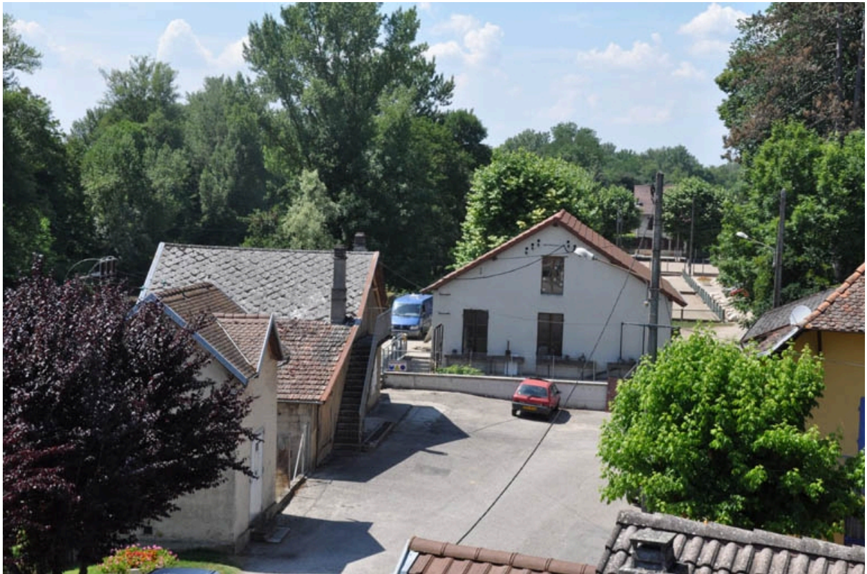
Vue de la centrale, façade est
